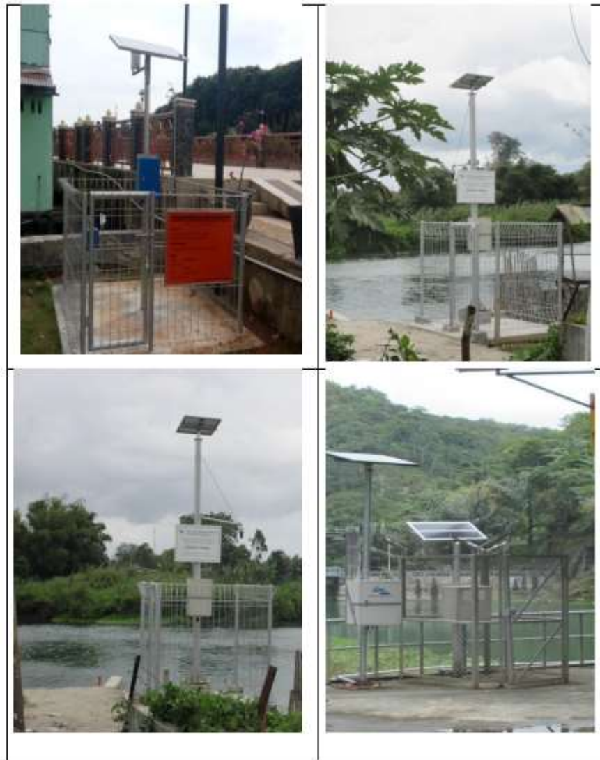
Gambar 6. Contoh Bangunan Pelindung Tidak Permanen
